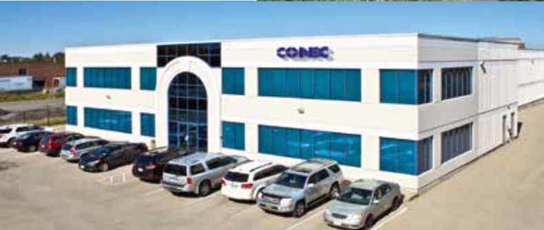
CONEC Canada, Brampton
